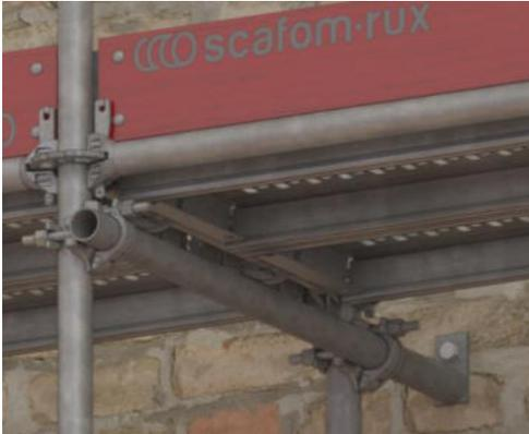
Figure 6.2c : Exemple de dispositif d'attache
